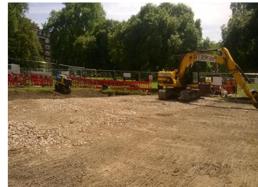
6) Piling Mat Install
